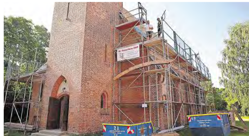
Eingerüstet ist die Großwoltersdorfer Kirche.
