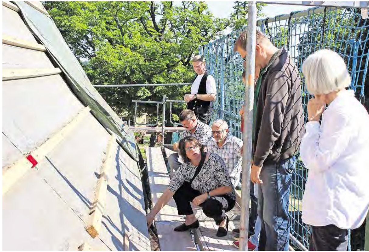
Baubesprechung auf dem Dach der Kirche.
